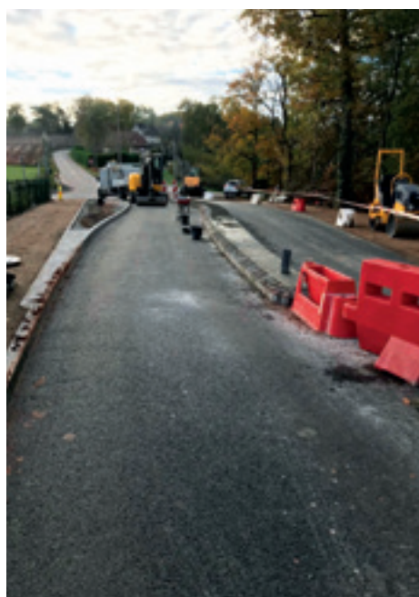
Aménagement du carrefour Croix de Marlophe
