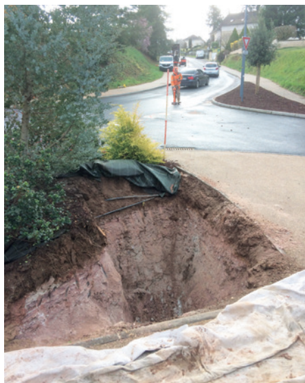
Préparatif du forage HTA sous le carrefour à la Mairie
