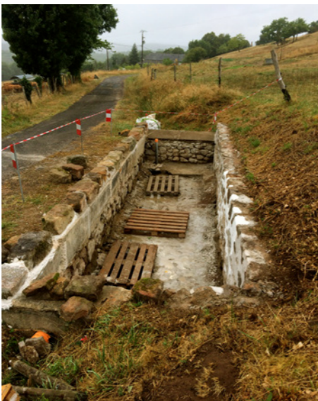
Le lavoir en cours de travaux
